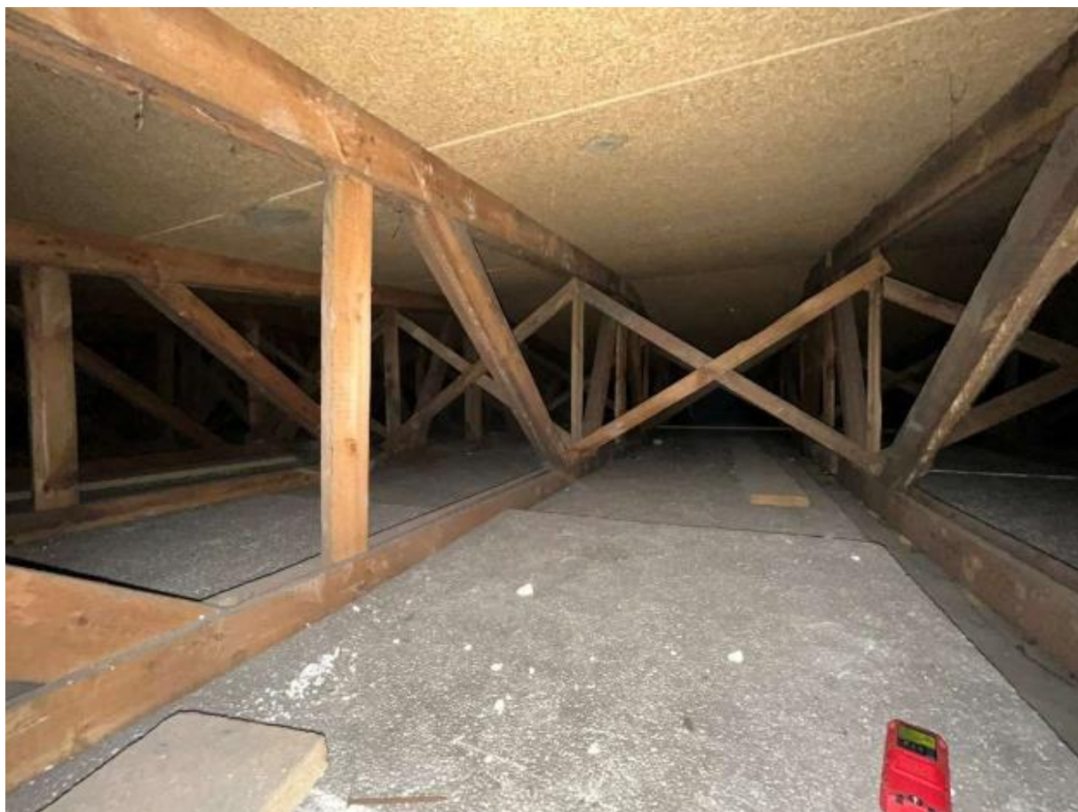
Widok konstrukcji więzara (stężenia pionowe, dźwigary) i warstw dachowych budynku A
